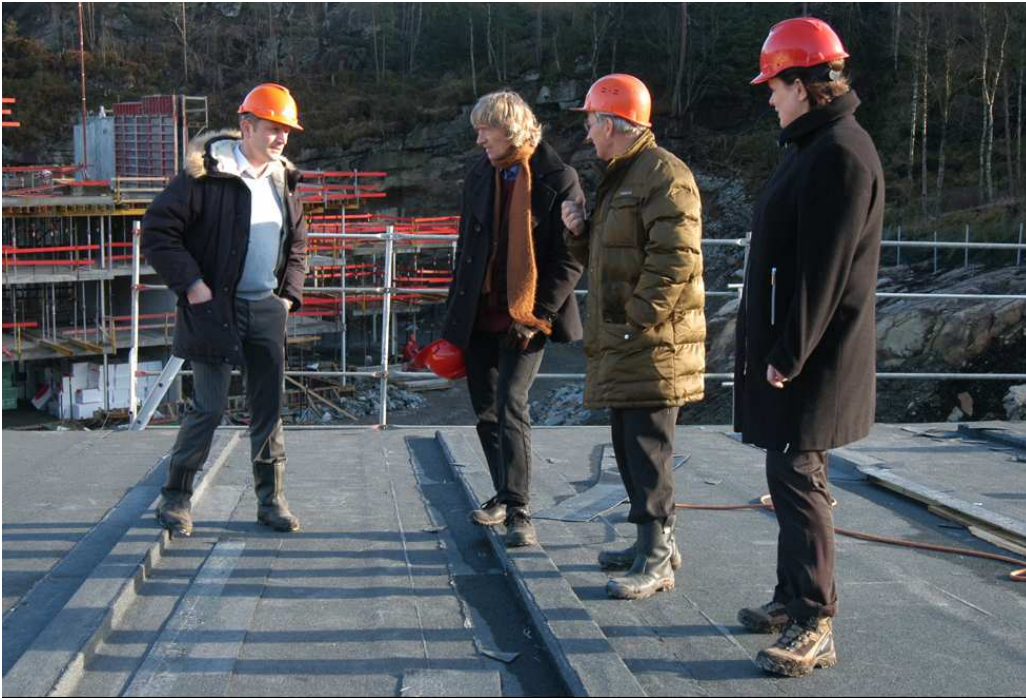
Figur 9: Befaring på taket av hus 4 (passivhus), der solfangere skal monteres.
