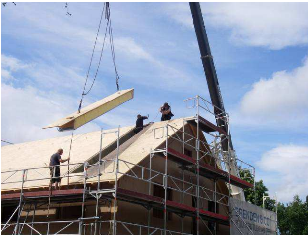
Figur 1 og 2 Siste takelement heises på plass (t.v.). Arbeidslaget fra Tyskland er fornøyd. Foto: Harald Ringstad
