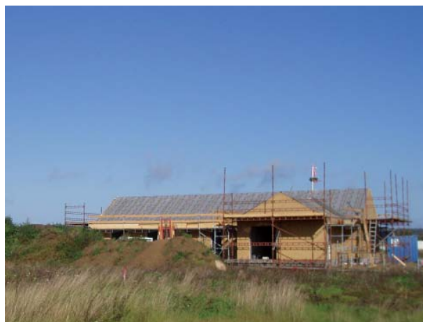
Parcelhus der er ved at blive bygget.
