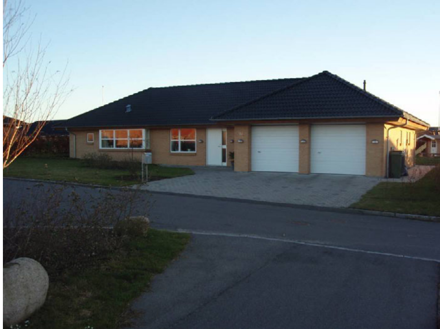
Figur B.2.10.1. Enfamiliehus opført i 2004.
