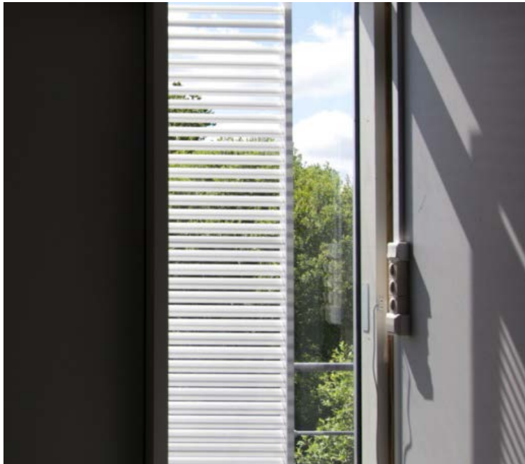
Figur 11. Energy Frames element med indbygget lamelafskærmning (persienne).
