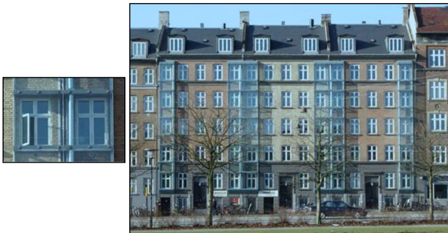
Figur B.2. Boligbebyggelsen i Fredensgade med de nye glasskakte. Foto tv. viser vindue åbnet ud i glasskaktten. Foto er gengivet fra projektrapport [B1].
