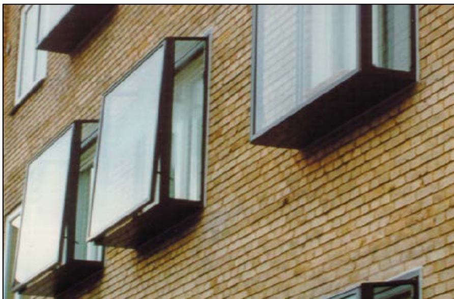
Figur C.2. De nye udhængsvinduer monteret på facaden mod Randersvej uden på facadevinduerne, der har indadgående rammer. Illustration fra [C2].
