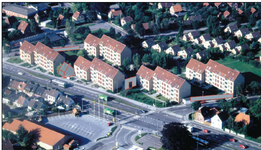
Figur C.1. Luffoto af Norgesparken med indtegning af udhængsvinduer samt støjskærme mellem blokkene mod Randersvej og ved sidegaderne. Illustration fra [C2].
