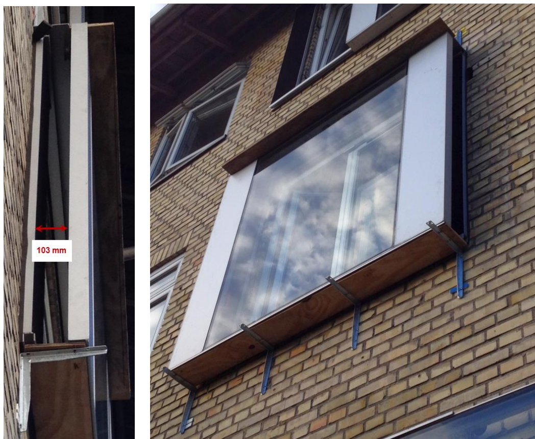
Figur 3 Den udrykkede lydskodde. Til venstre den udvidede spalte.
