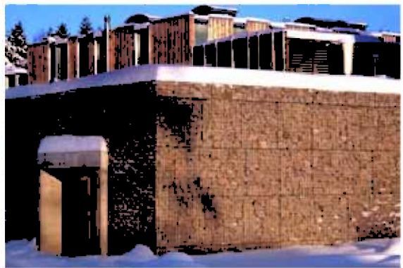
Kvernhuset ungdomsskole. Foto arkitektene PIR II
