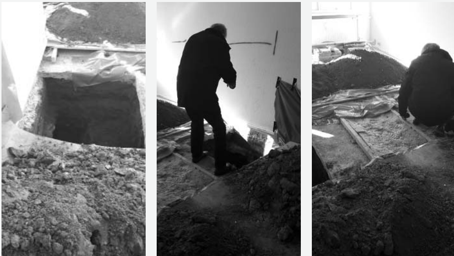
Feltfoto 7, 8 og 9. Omfattende udgravninger i forbindelse med de indledende undersøgelser: Hvor slagtermaterialet havde sunket sammen og suget fugt til sig og videre op i konstruktionen.
