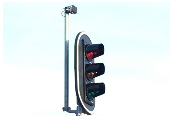
Figur 4: Radar (placeret i eksisterende signalmast) til detektering af trafikanter i et signalreguleret kryds.
