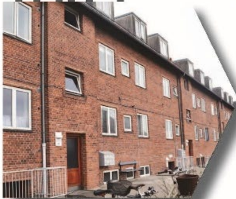
Bygning som helhed
