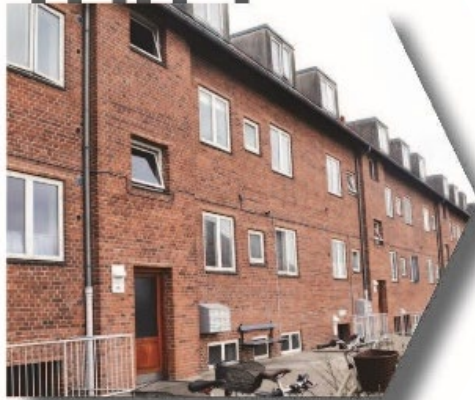
Bygning som helhed
