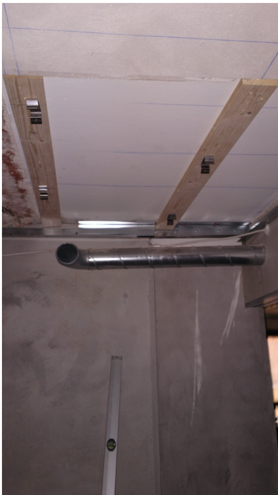
FIGUR 23. Der må ofte etableres forsænkede lofter, som kan skjule de nye ventilationsrør.
