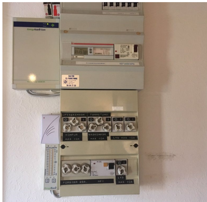
Figur 8. Visualiseringen af ens hverdagsforbrug – at man kan se, når strygejernet og elkedleren er tændt – fremhæves som en effektiv og ikke-teknisk måde at synliggøre, hvad strøm egentlig er for en ressource. Her en ældre model, som grafisk illustrerer husholdningens øjeblikkelige strømforbrug (til venstre for elmåleren).
