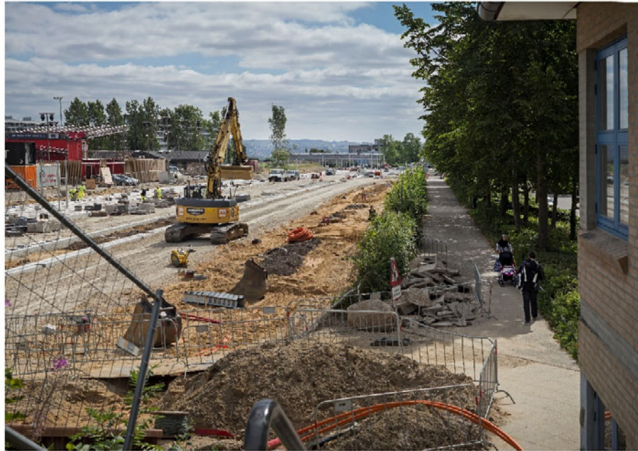
Figur 6: Ny infrastruktur skal kæde Gellerupparken bedre sammen med den omkringliggende by. Her Karen Blixens Boulevard fotograferet under anlægsfasen i 2017.
