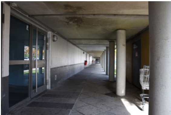
Figur 10: Ankomstforholdene ud mod parkeringsarealerne langs højblokkene ud mod Åby Ringvej er klemte. I Blok 4, der er pilotprojekt for fremtidige renoveringer, er det blevet forbedret radikalt – fodgængerdækket i stueetagen er revet ned, og et dobbelthøjt ankomst areal med gennemgang på tværs af boligblokken er blevet etableret.
