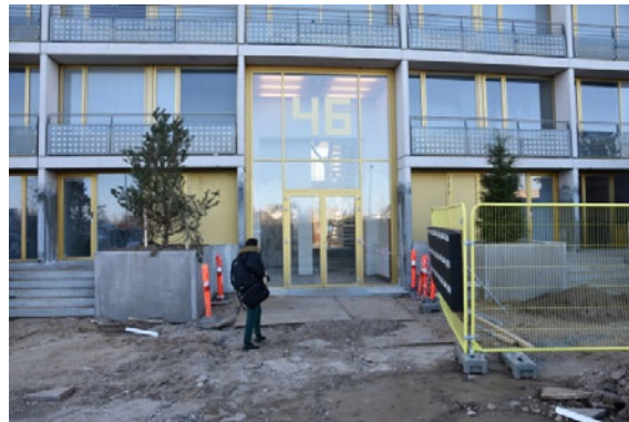
Figur 10: Ankomstforholdene ud mod parkeringsarealerne langs højblokkene ud mod Åby Ringvej er klemte. I Blok 4, der er pilotprojekt for fremtidige renoveringer, er det blevet forbedret radikalt – fodgængerdækket i stueetagen er revet ned, og et dobbelthøjt ankomst areal med gennemgang på tværs af boligblokken er blevet etableret.
