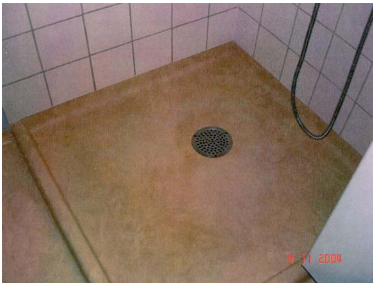
Figur 41. Gulv i bruseniche før hultagning.
