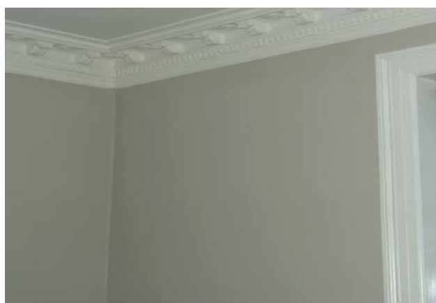
Figur 36. Overgang mellem lejlighedsskel, facade mod gade (til højre) og gavl (til venstre). Det vandrette lejlighedsskel er et traditionelt opbygget træbjækelag med indskud og pudset loft. På det termografiske billede til højre repræsenterer farven rød 18 °C og farven mørkeblå 12 °C. Til venstre er vist et sædvanligt fotografi taget fra samme sted.
