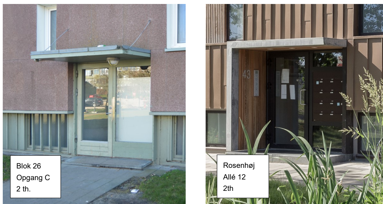
FIGUR 9. Før (tv) og efter (th). Renovering af opgange med nye adresser.
