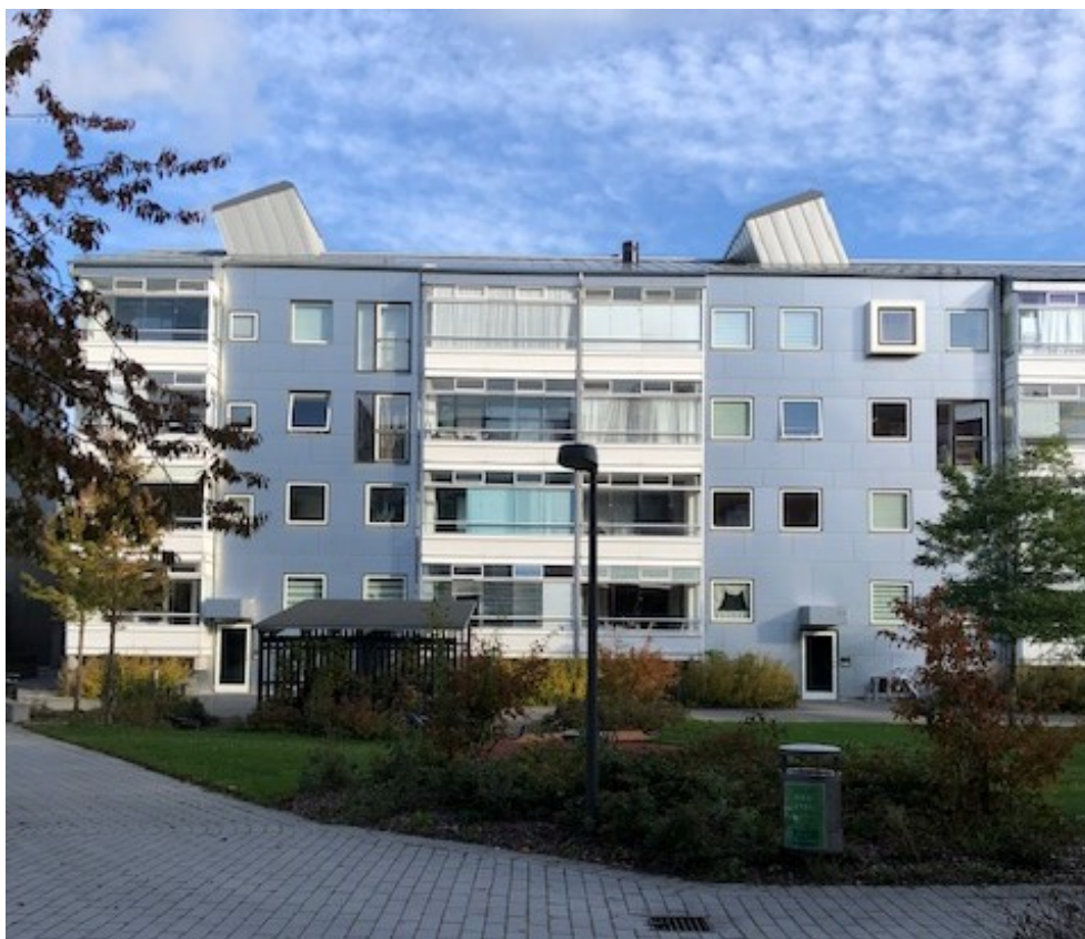
FIGUR 52. Mange altaner er dækket af lange gardiner og flere bruges primært til opmagasinering. Foto: Signe Rudá, BUILD.
