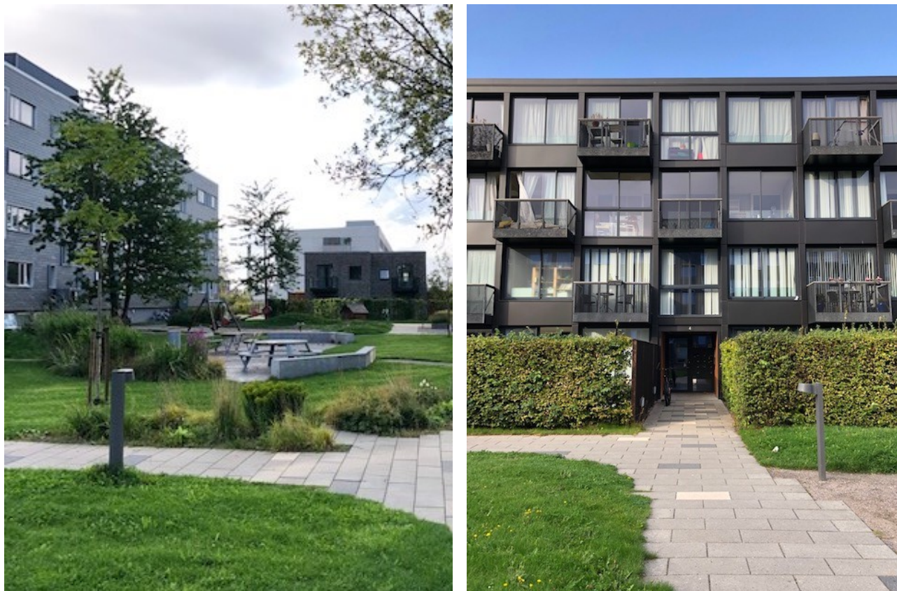
FIGUR 14. Semi-private gårdrum mellem boligblokkene (tv) hvor der med omdannelsen blev lavet gennembrud i bebyggelsen for at give direkte adgang til udearealerne. De private haver er afgrænset af høje hække. Foto: Signe Rudå, BUILD.
