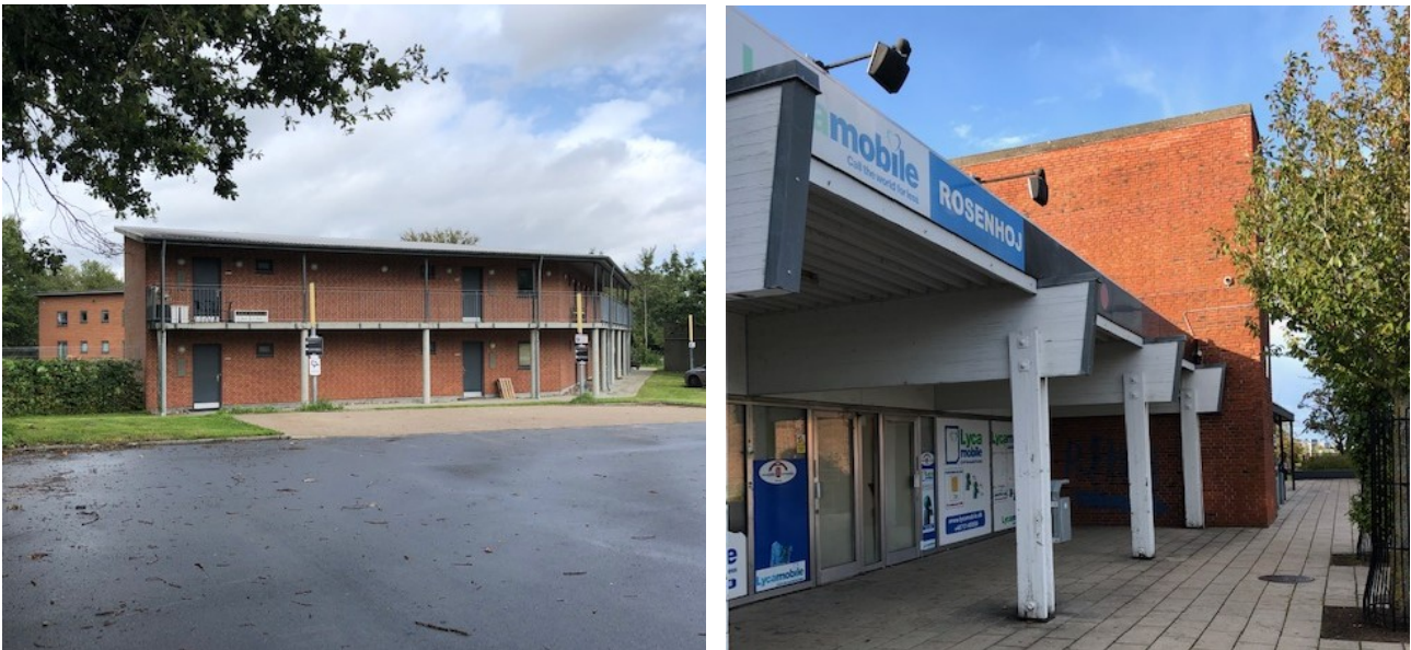
FIGUR 27. Uro og stofsalg er koncentreret i øde områder, hvor folk ikke færdes, og hvor der ikke er udsyn fra boligerne, her ved ungdomsboligerne (tv) samt det tomme butikstov (th). Fotos: Signe Rudå, BUILD.
