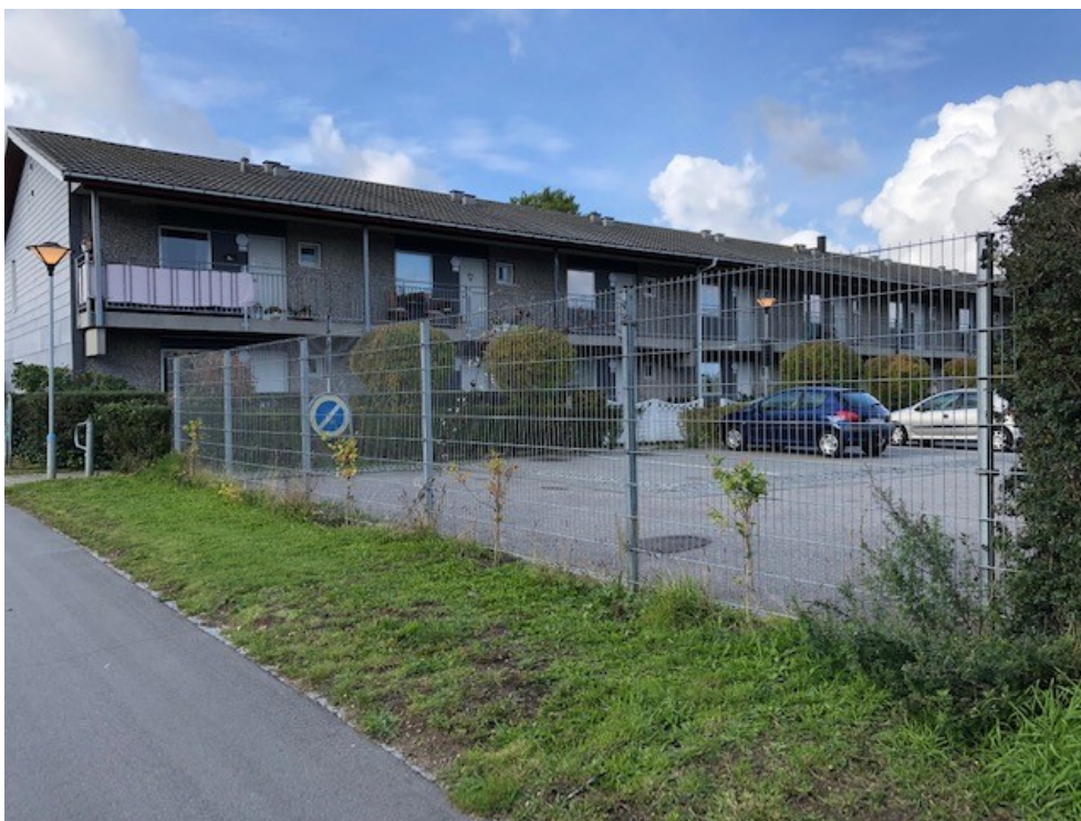
FIGUR 60. Metalhegn opsat i den almene boligforening Skovengen, som grænser op til Egedalsvænge. Foto: Signe Rudå, BUILD.
