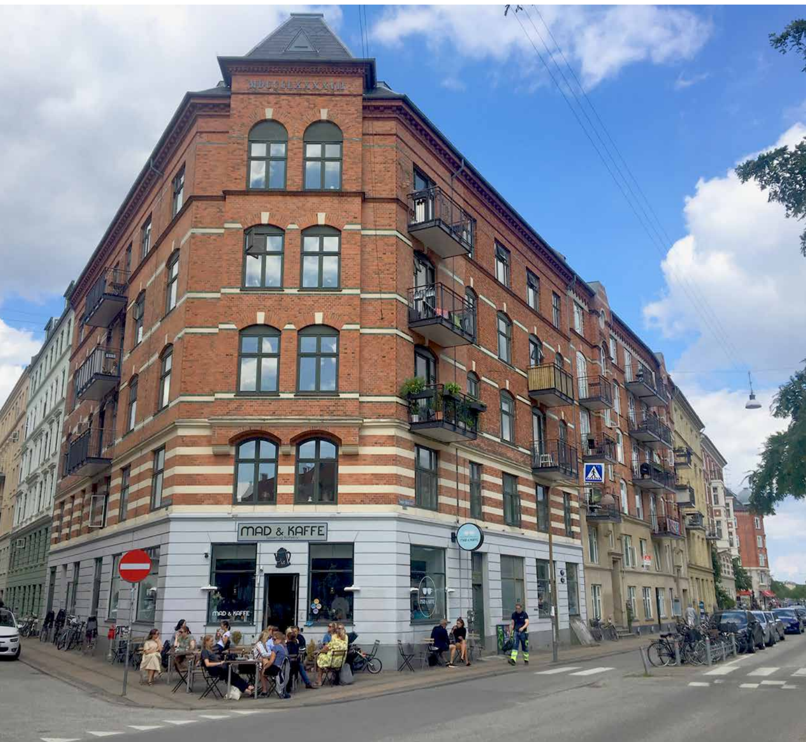
Figur 4. På Vesterbro er det kun nogle af lejlighederne, der har altaner mod gaden. (Foto: BUILD).
