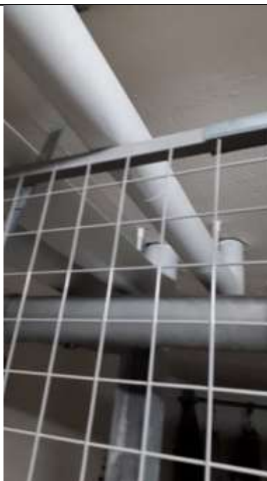
Billede 4: viser rørføring fra boligdelen og ned i kælderen
