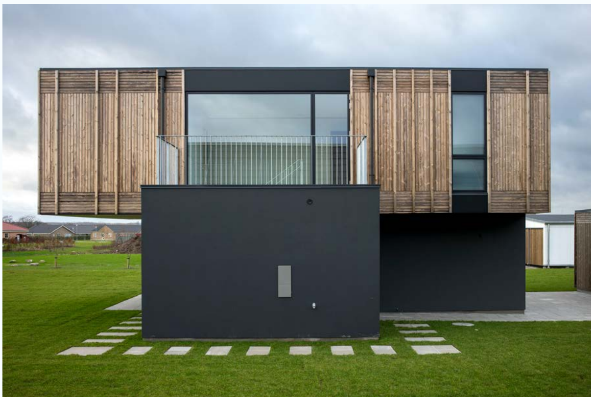
Det Foranderlige Hus i Nyborg viser, at der kan spares både økonomisk og miljømæssigt ved at bygningskomponenter genbruges i nye sammenhænge. Første salens skillevægge består af skabe, som kan flyttes. Kreditering: Realdania By & Byg / Helene Høyer Mikkelsen. (Arkitekter: Henning Larsen, GXN).
