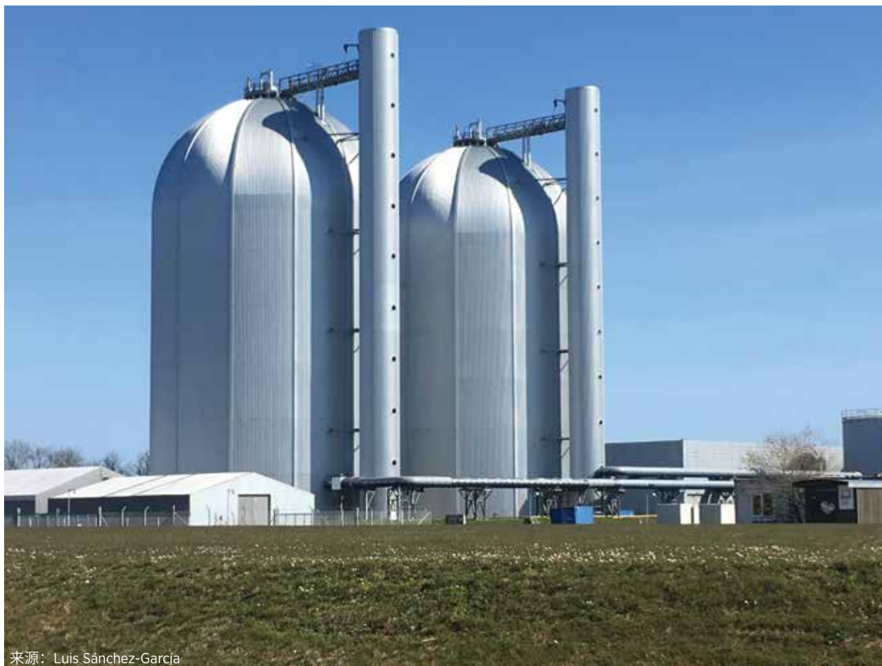
照片 4：丹麦哥本哈根 AvedøreKraftværket 的蓄热装置（44,000 m 3 ）
