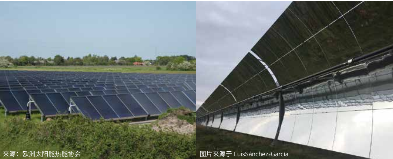
照片 2：丹麦 Løgumkloster 配置平板集热器的太阳能发电厂（左）和丹麦 Brønderslev 配置槽型抛物面 CSP 的太阳能发电厂（右）
