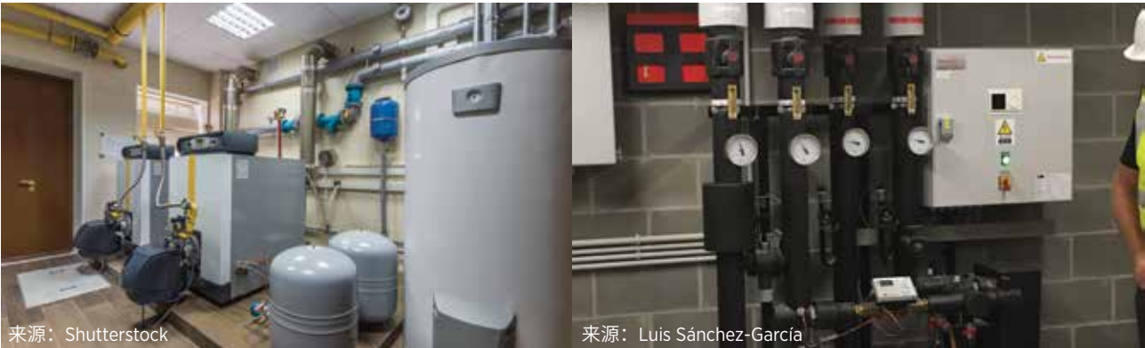
照片 5：燃气锅炉房中的燃气锅炉（左）和比利时某建筑中的换热站（右）
