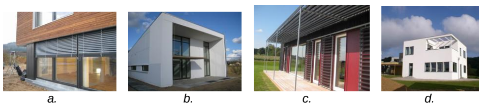
Figur 3.5. Eksempel på udvendig solafskærmning.
