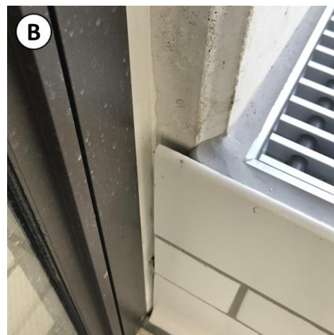
FIGUR 2. Observationer af flisearbejde fra besigtigelse af Roskilde Badet. Note: A: Flisearbejde i wellness-afdelingen, hvor det ikke er lykkedes at lave et pænt flisehjørne med fuger i samme bredde. B: Svævende flise ved indgang til wellness-afdelingen, der ikke hæfter til underlaget. Kilde: AAU BUILD.
