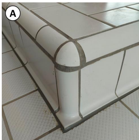
FIGUR 2. Observationer af flisearbejde fra besigtigelse af Roskilde Badet. Note: A: Flisearbejde i wellness-afdelingen, hvor det ikke er lykkedes at lave et pænt flisehjørne med fuger i samme bredde. B: Svævende flise ved indgang til wellness-afdelingen, der ikke hæfter til underlaget. Kilde: AAU BUILD.
