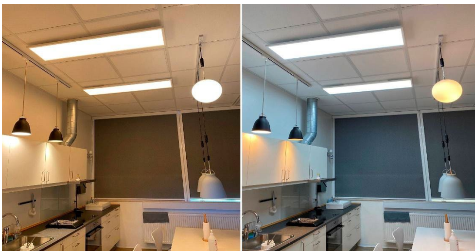
FIGUR 12. Demonstration af loftspaneler med farveskift, bemærk hvordan den runde lampe og penderne synes meget mere gule på billedet til højre (det er dog kun de rektangulære paneler der er justeret). Foto: Signe Tornøe Tødten.
