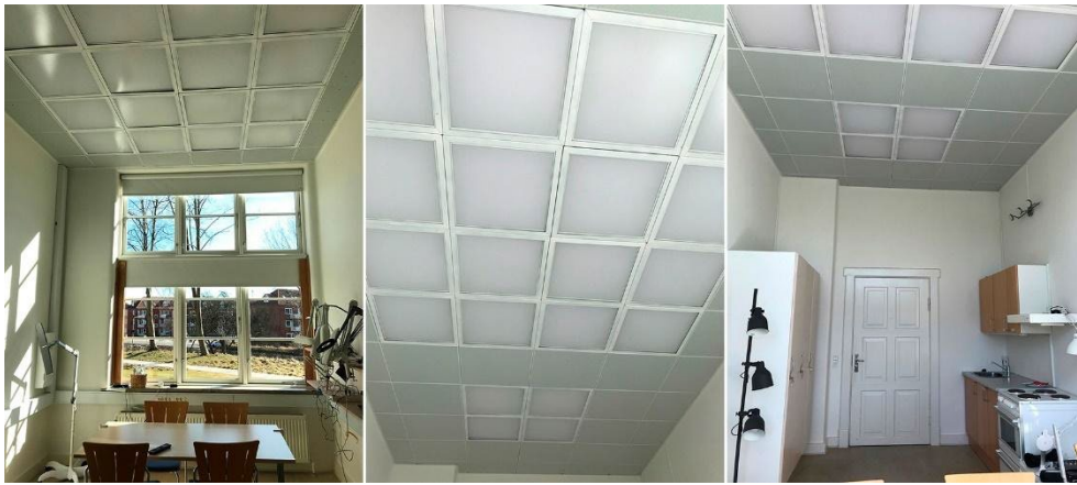
FIGUR 7. Lyslab i Århus, system for loftsbelysning etableret i 2020, køkkensituation og spisebord/arbejdsplads. Foto: Dorthe Bräuner Berge.
