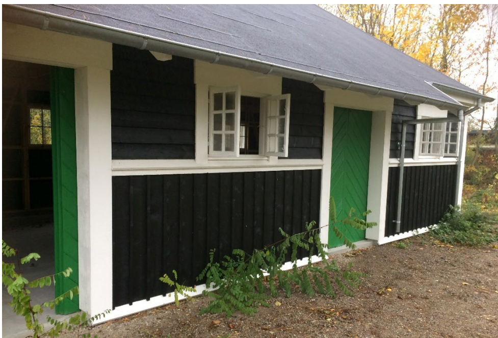
FIGUR 17. Det renoverede pakhus, som skal bruges til depot og cykelskur. Foto: Niels Haldor Bertelsen (2018).
