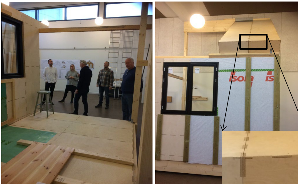
FIGUR 15. 1:1-modeludsnit af modulhuset, som er opstillet hos Lykke + Nielsen Arkitekter i Stege, der er arkitekt og projektrådgiver på modul-forsøget. Foto: Niels Haldor Bertelsen (2018).
