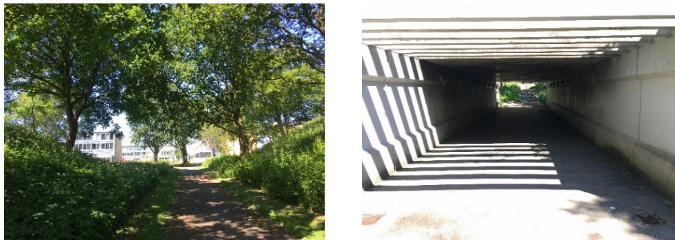
FIGUR 8. Tv. Den grønne kile mod vest er et attraktivt rekreativt område, men beplantningen er nogle steder tæt og skaber en fysisk barriere ml. boligområdet og området på den modsatte side af Degnevej. Th. En mørk tunnel, der skaber forbindelse på tværs af den grønne kile.
