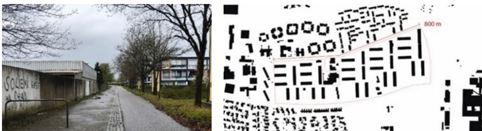
FIGUR 8. Tv. Skovparken Centeret set fra den nord-syd-gående sti, der løber mellem centeret og Skovparken. Facaden til centeret fremstår lukket, misvedligehold og skaber en fysisk barriere mellem de to boligafdelinger. Th. Kortet viser bebyggelsesstrukturen i og omkring Skovvejen/Skovparken samt en afstandsmåling langs Skovvejen og Skovparken
