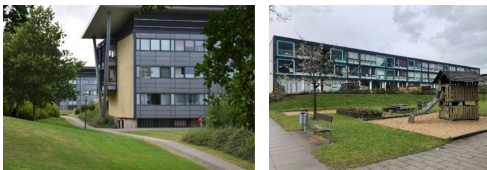
FIGUR 6. Tv. Boligblokke i Skovparken set fra gårdsiden med glasinddækkede altaner og ensidig taghældning. Th. Skovparkens boligblokke set fra indgangssiden med stort tagudhæng og ekstra etage med tagboliger.
