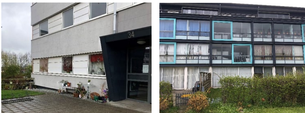
FIGUR 12. Tv. Et af de få eksempler på personlig prægning i Skovvejen. Th. De glasinddækkede altaner i Skovparken skaber et mangfoldigt udtryk af forskellige måder at anvende det uopvarmede areal. Nogle steder ses sirligt opstillede potteplanter og andre steder er ophængt gardiner eller anden form for afskærmning.
