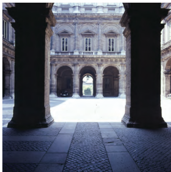
Fig. 1.33 Helt fremme, ud for baglinjen af pillerne mellem vestibule og loggia, åbner gårdrummet sig foran én. Pillerne indrammer de tre midterste fag på den modsatte side, som igen indrammer tre fag på bagvæggen. Toppen af kapitælerne flugter med underkanten af gesimsen mellem 1. og 2.sal, og toppen af den nederste kapitæl flugter med pilastrener kapitæler på 1.sal.
