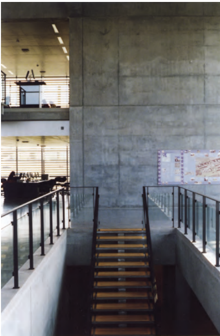
Fig. 3.38 Støbefugerne i væggen længst mod vest følger ikke de vandrette delinger i rummet, bortset fra den midterste fuge, som deler væggen i en øvre og en nedre del. Den ligger i samme niveau som dækket mellem stue og 1.sal. På rammen som står opad væggen, er denne linie fræset ud, efter at være støbt. Også rækværkets overkant på 1.sal der slutter 1 cm under en støbefuge i den lodrette ramme, som rækværket støder op til, fig. 3.8.
