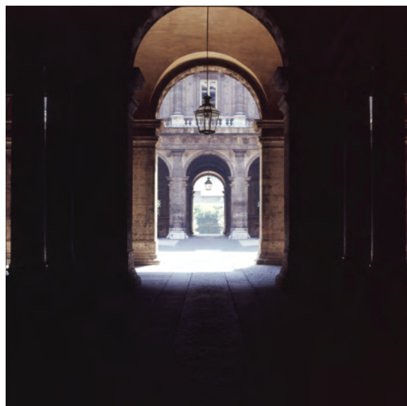
Fig. 1.31 Lige indenfor i vestibulen i linie med halvøjlerne som flankerer porten, med en øjenhøjde på 161 cm, indrammer buen til gården lige netop vinduet på gårdens modsatte side. Overkanten af kapitælen flugter med balkonkanten på den modsatte side af gården, og den nederste kant af kapitælen flugter med gesimsen.
