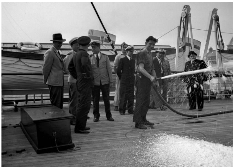
Fra en demonstration af et skumslukningsanlæg på et skib. Foto: Danmarks Tekniske Museum
