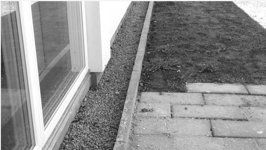
Feltfoto 17. Billedudsnittet viser det nyetablerede omfangsdræn og de renoverede facader.
