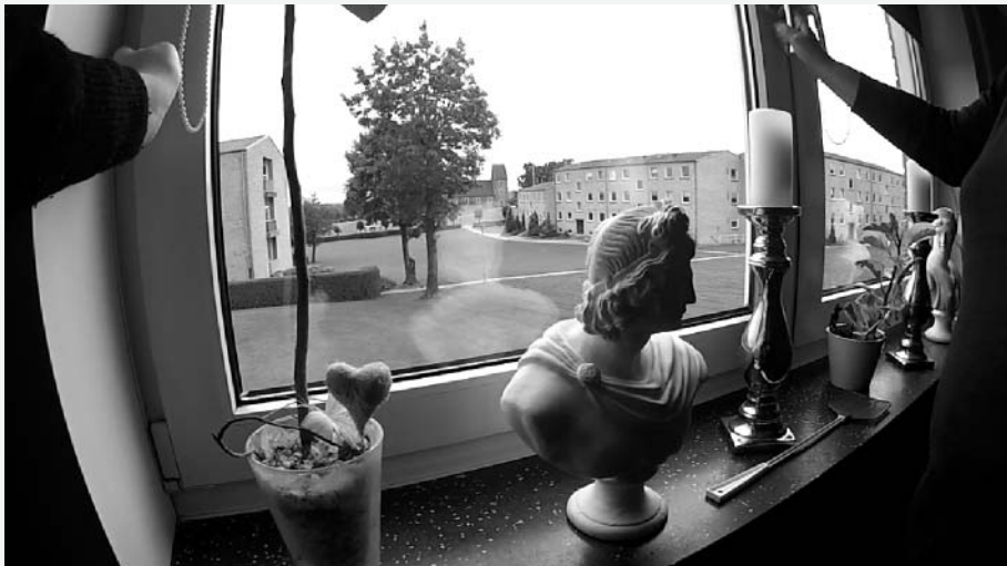
Feltfoto 2. På trods af hyppig udluftning og god opvarmning, var væggene i denne gavllejlighed tydeligt fugtige. Problemet var særligt tydeligt rundt om vinduespartierne.
