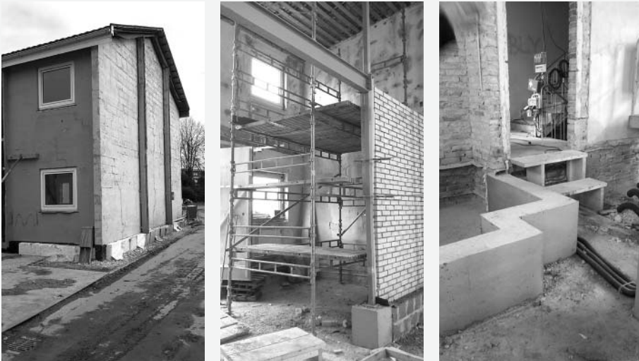
Feltfoto 14, 15 og 16. Tre fotografier fra en meget omfattende renovering, hvor det mere eller mindre kun er den ydre skal der står tilbage fra det oprindelige byggeri.
