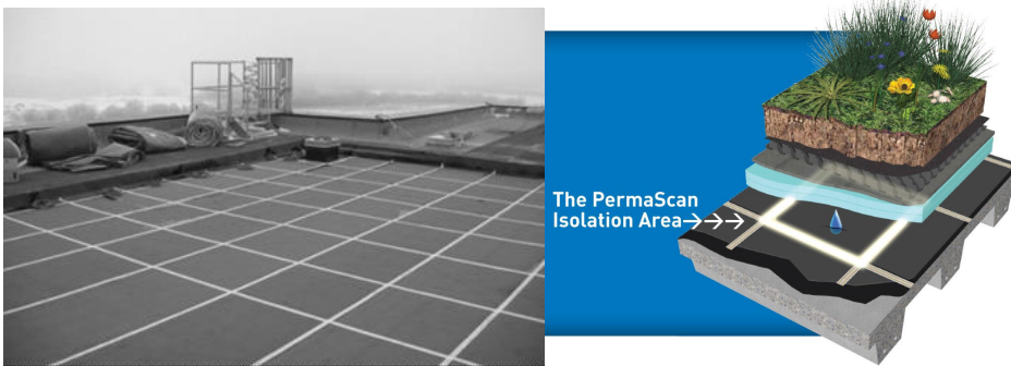
Figur 17. (a) letvægtstrådnat, og (b) implementering af letvægtstrådnat i tagkonstruktion. Kilde: Udlånt af Detec Systems LLC, PO Box 31725, Bellingham, WA 98228, USA
