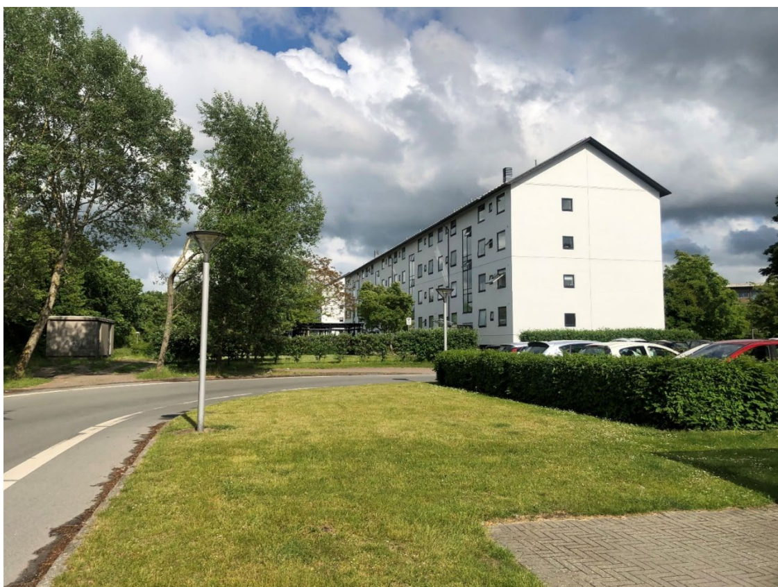
Øverst: Butikstorvet centralt i boligområdet fremstår nedslidt og delvis tomt. Nederst: Blokkene i Schackenborgvænge er nyrenoverede og adskiller sig udtryksmæssigt fra de øvrige blokke.
