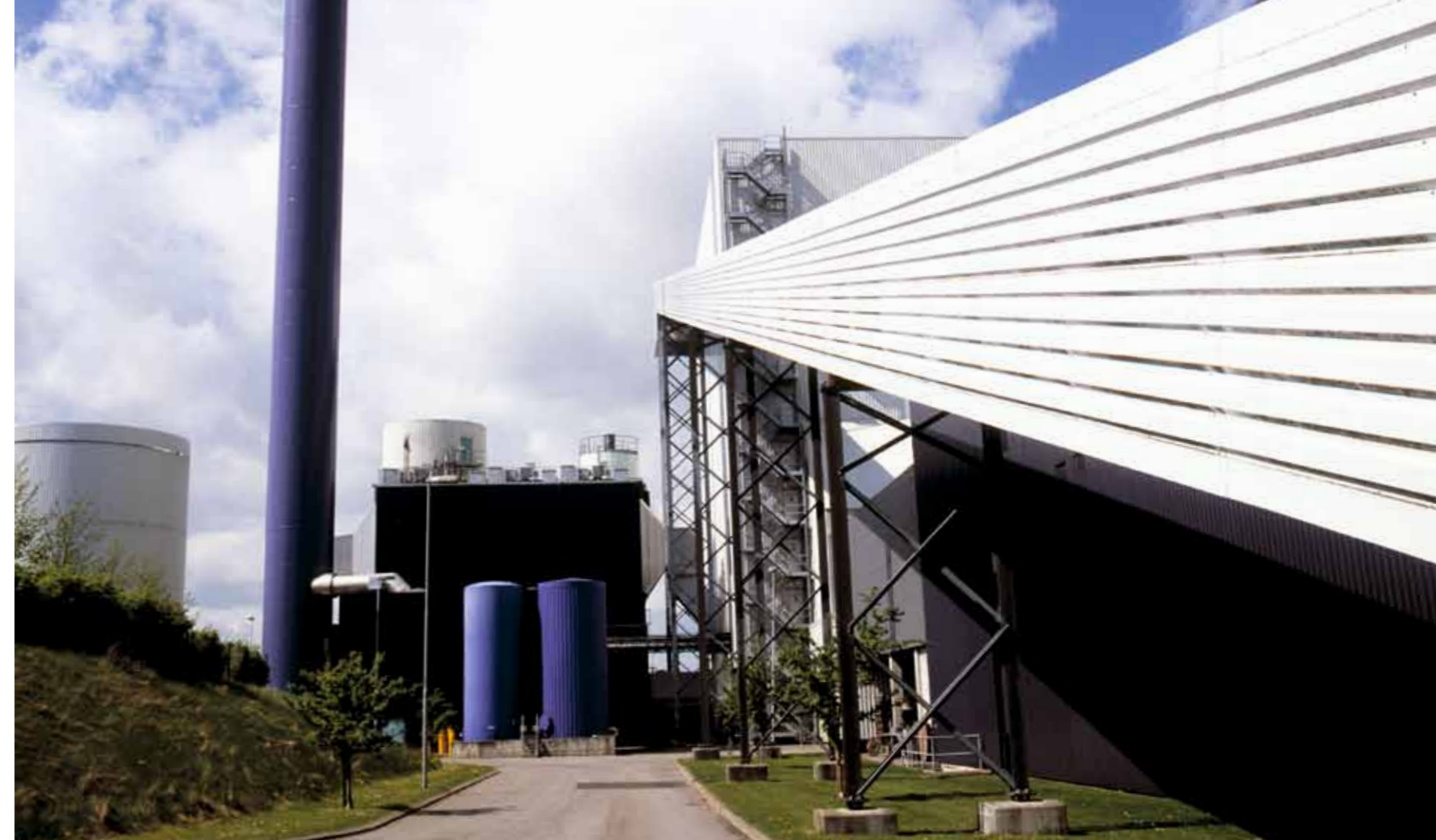
Decentralt kraftvarmeværk i Grenå
