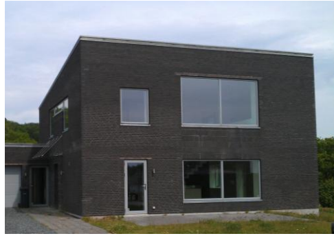
Figur 3.5: Hus 47: Manglende solafskærmning
