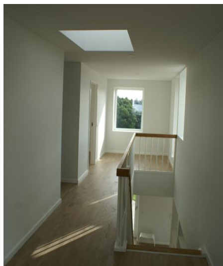
Figur 5.10: Ovenlysvindue i hus 49
