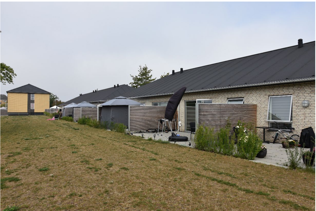
Afdeling 21, hvor en toetagers boligblok er blevet nedrevet til sokkel og ombygget til rækkehuse (nederste billede).
