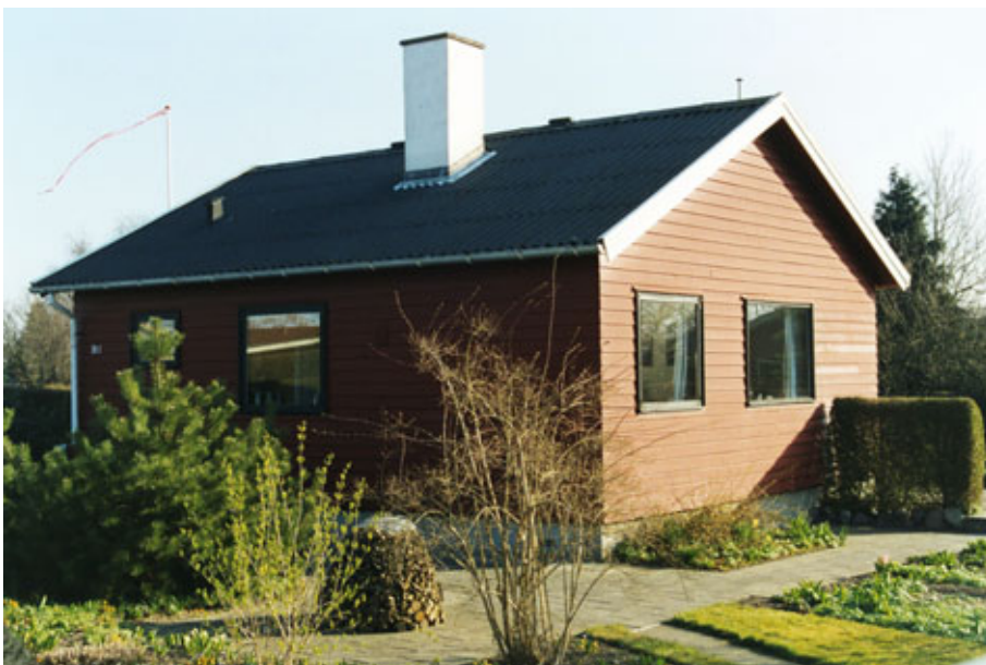
Et Finnehus i sin grundform, uden tilbygninger. Vinduerne er dog udskiftet.
