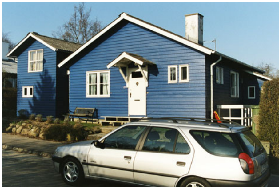
Et Finnehus med et tilbygget anneks.
