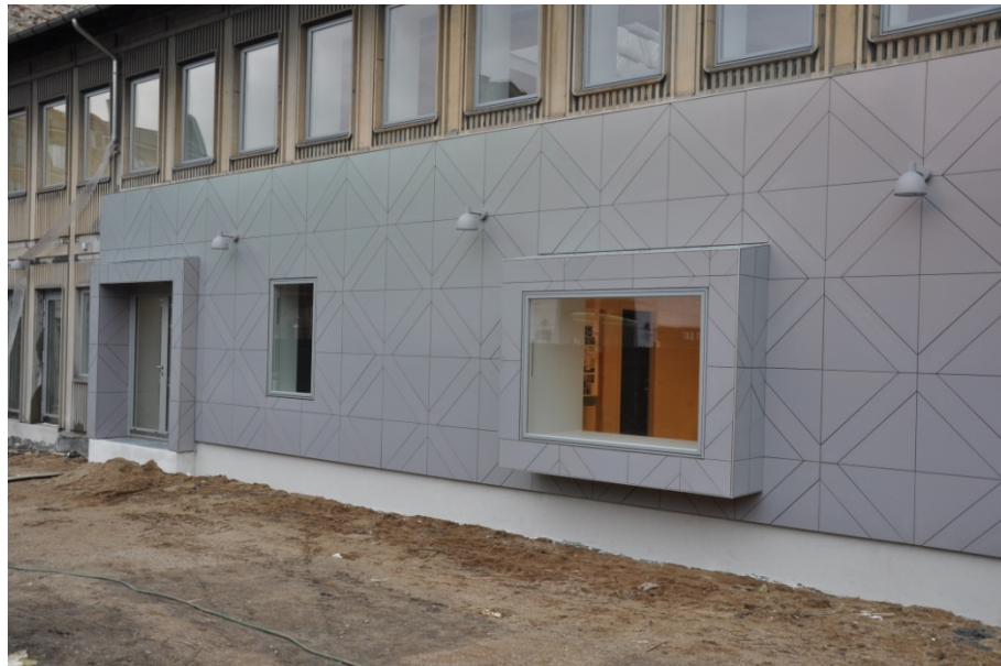
Figur 4. Billede fra renovering af facade i Osram-bygningen, København (Foto: Wissenberg A/S).
