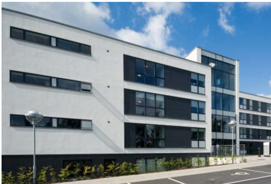
Figur 117. Facader mod øst på Kildebakken.
