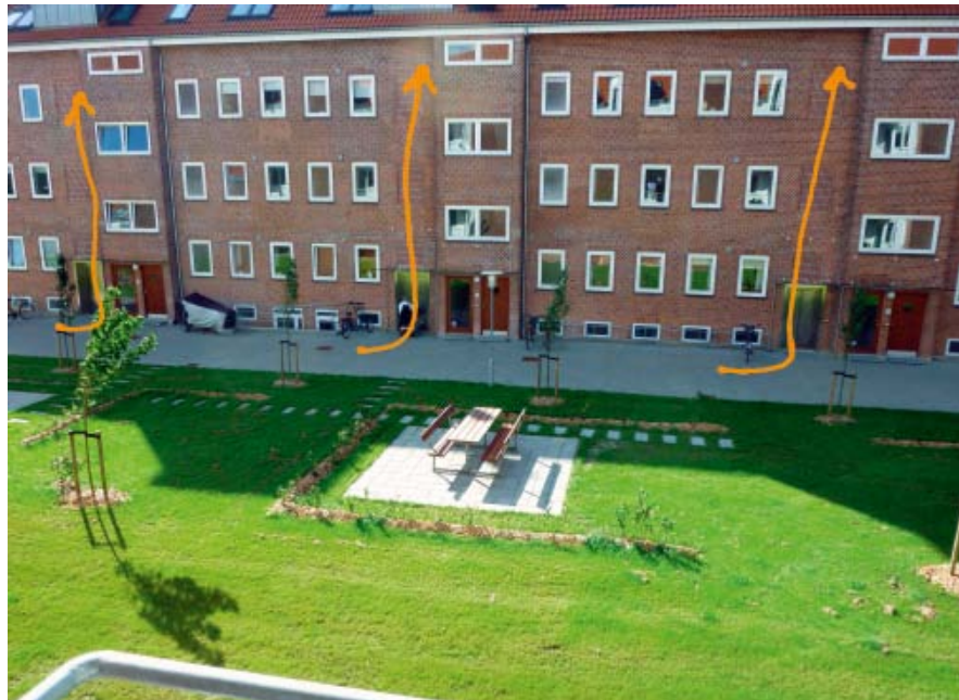
Figur 102. Godt eksempel på indbygning af elevatorskakt muliggjort af lejlighedssammenlægninger.
