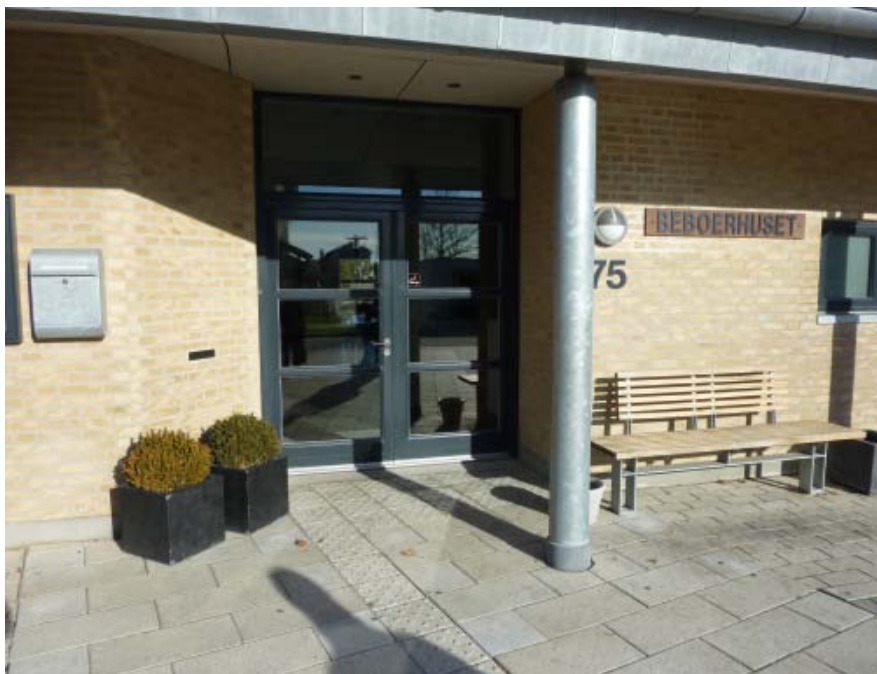
Figur 79. Indgang til fælleshus med gode detaljer: (1) vandret repos, (2) ledelinje frem til indgang, (3) nummerskilt med god kontrast, (4) markering med belysning, (5) letgående dør.
