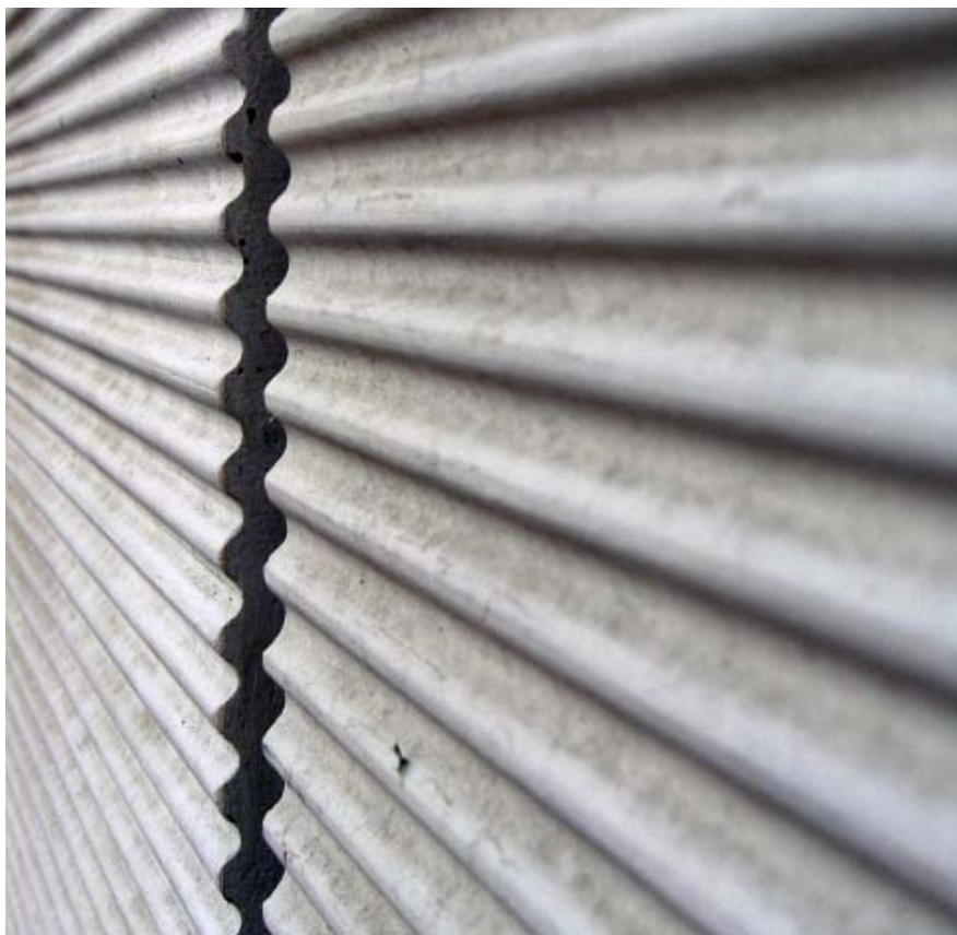
Figur 57. De profilerede fiberbetonelementer på Gyldenrisparkens gavle.
