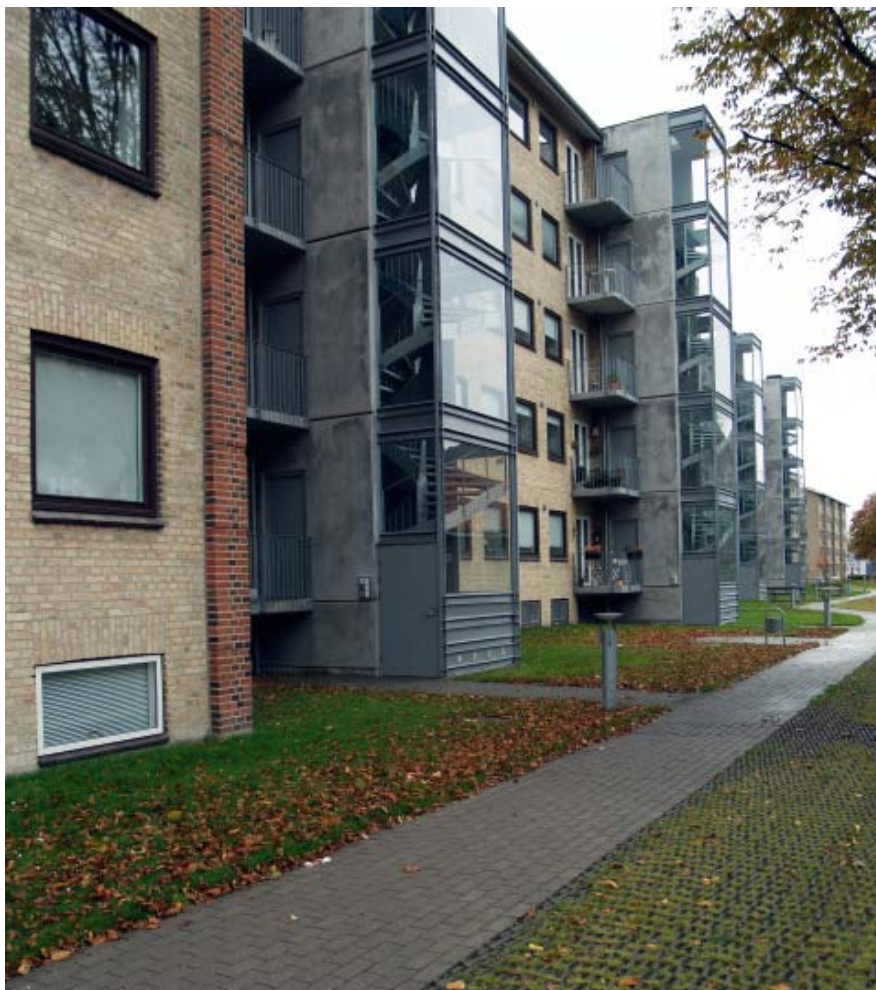
Figur 110. Tilbygninger med nye trappetårne.
