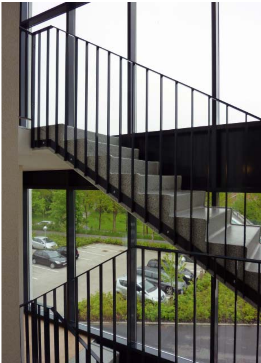
Figur 121. Trappeopgangene er uden hånd- lister i begge sider, og håndlisterne mindre gribeegnede.
