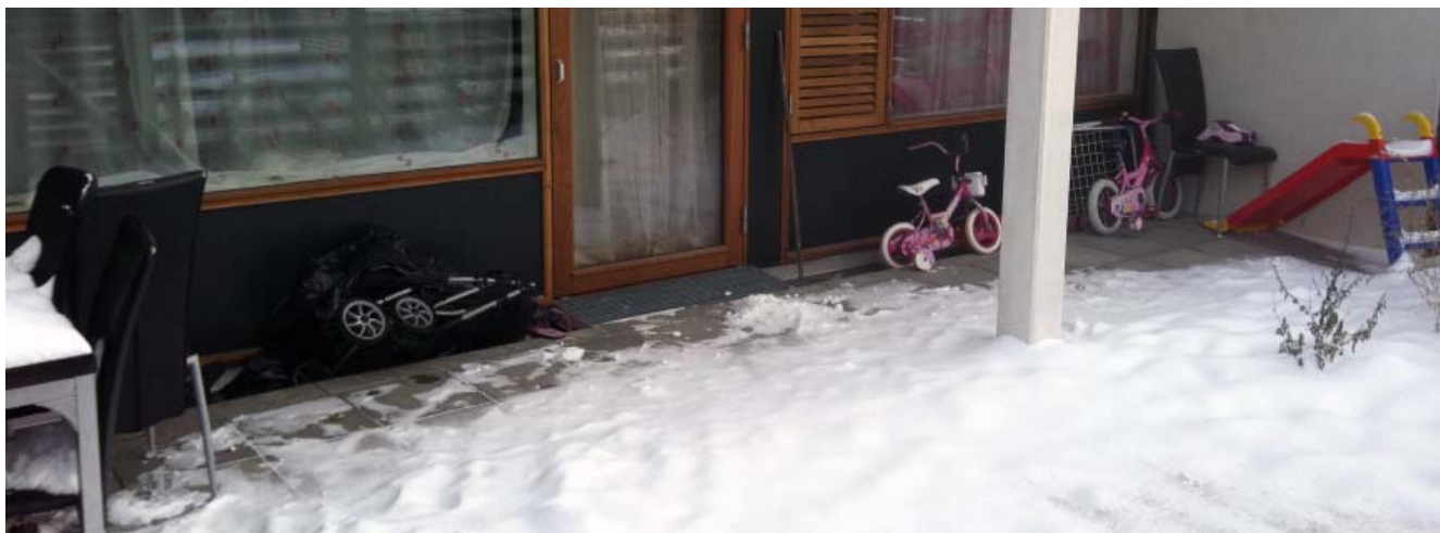
Figur 37. Hævet terræn til stueetages haveside og fugtsikring med åben rende. Gyldenrisparken.
