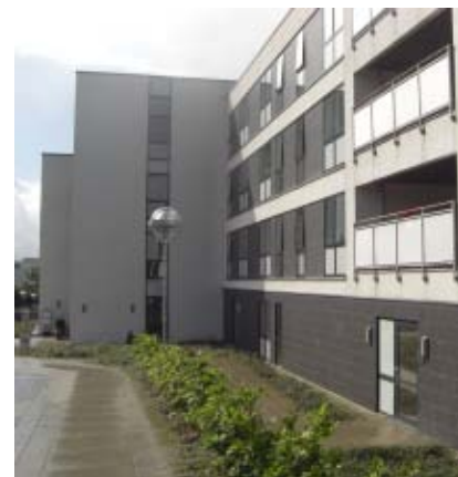
Figur 24. Billedet viser det arkitektoniske udtryk, som blev skabt ved ombygning af boligblok til plejehjem.
