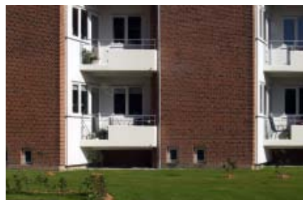
Figur 98. Sprotoftens altaner før og efter den gennemførte renovering.
