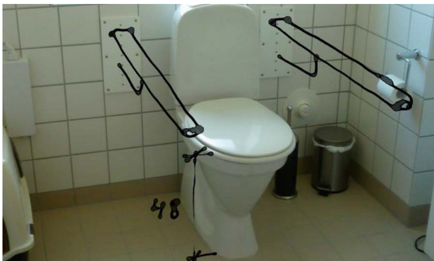
Figur 42. Højt toilet med armstøtter som kan monteres i løbet af kort tid (Sprotoften).
