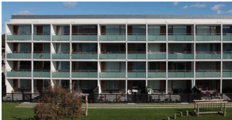
Figur 56. Renoveringen af altanfacaderne er sket med udgangspunkt i bebyggelsens oprindelige arkitektur - altanerne er blevet større, men glasbrystningerne sørger for, at det ikke sker på bekostning af dagslysforholdene i de bagvedliggende lejligheder.
