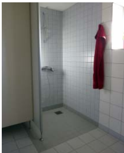
Figur 41. Fleksibel løsning med bruseområde med aftagelig væg og flytbart skab. Skydedør friholder vendeareal for dørøpslag (Hånbæk).
