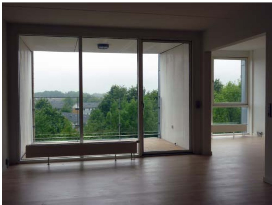
Figur 68. Rummelige altaner med gulv hævet til samme kote som stuegulv.
