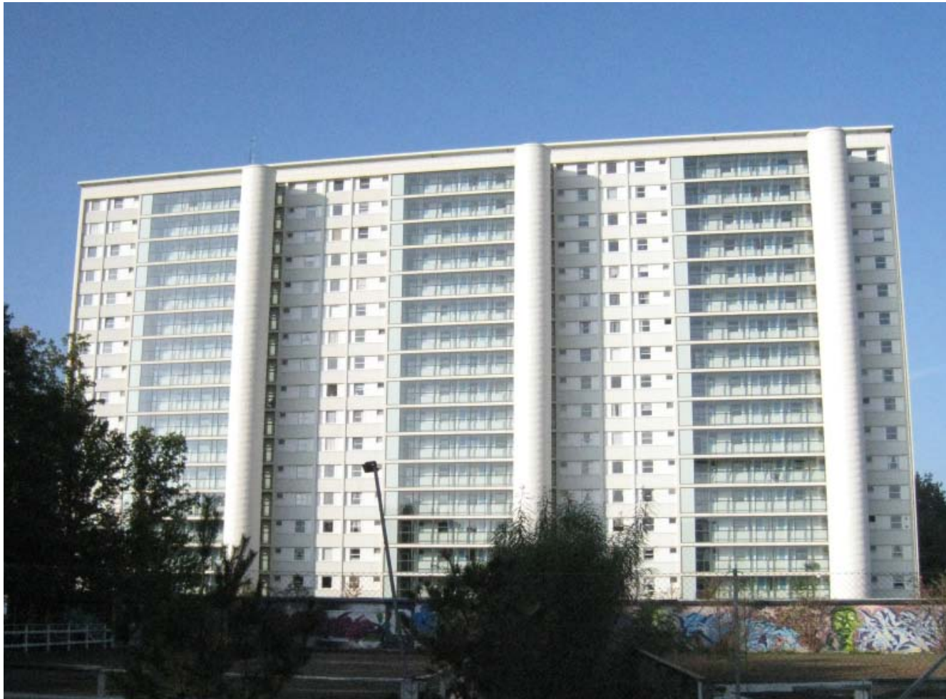
Figur 7. Milestedet, hvor renoveringen har bygget videre på bebyggelsens oprindelige kvaliteter.
