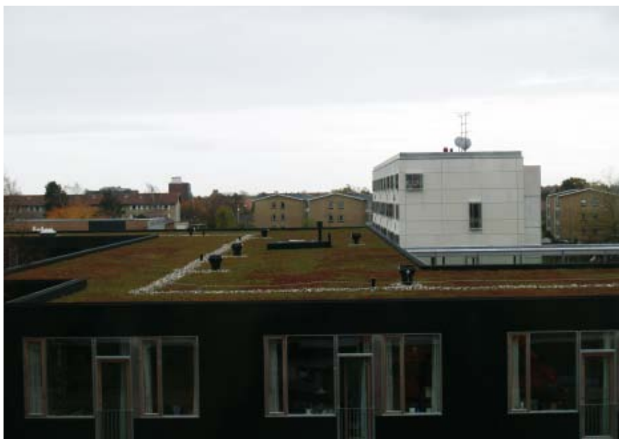
Figur 29. Grønne tage, som her på den nyopførte daginstitution i Gyldenrisparken, optager en stor del af regnvandet der falder på tagfladen, og bidrager til at aflaste kloakkerne under regnskyl.
