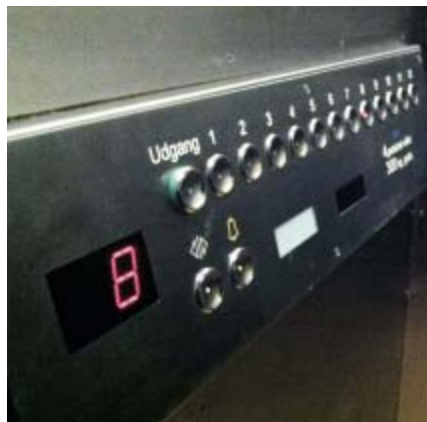
Figur 87. Til venstre: Indkøbsvogne i elevatorer kan være lige så hyppigt forekommende som rollatorer og kørestole. Til højre: Vandret betjeningspanel.
