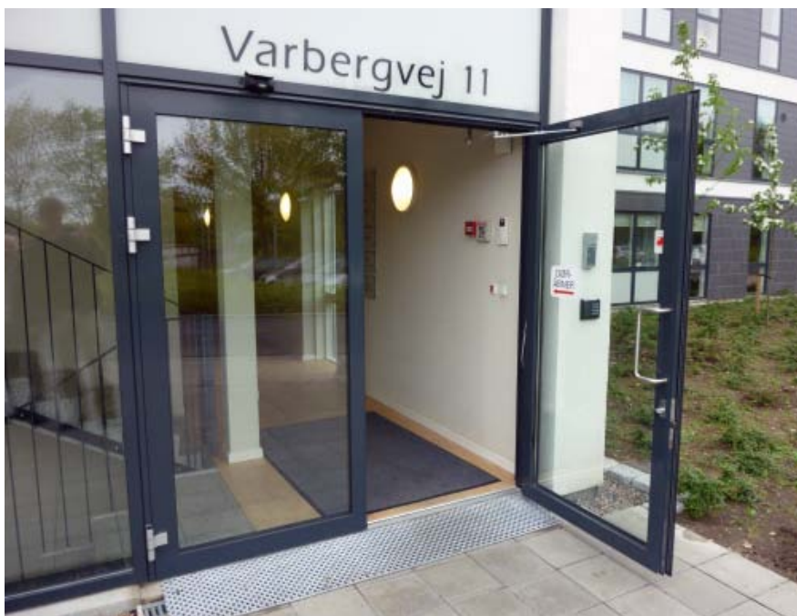
Figur 120. Overdækning af afvandingskanal med hulplade for at opnå lav dørtrinshøjde.
