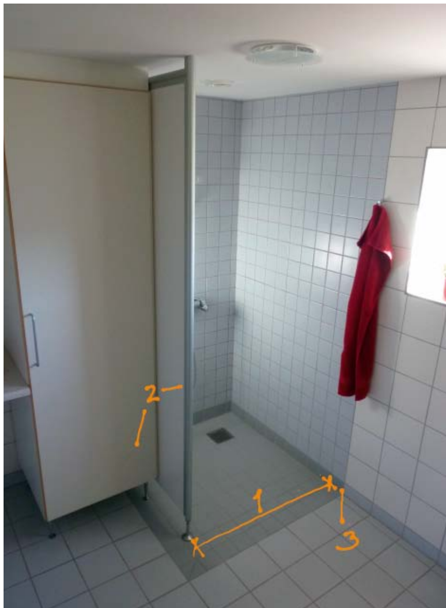
Figur 78. Adgang til bruseplads kan ske fra to sider, hvis væg og skab (2) flyttes. Adgang til bruser kan foregå i fuld bredde (1). Bruseområdet har en skråt afskåret forsækning, som badestole og kørestole lettere kan køre over.
