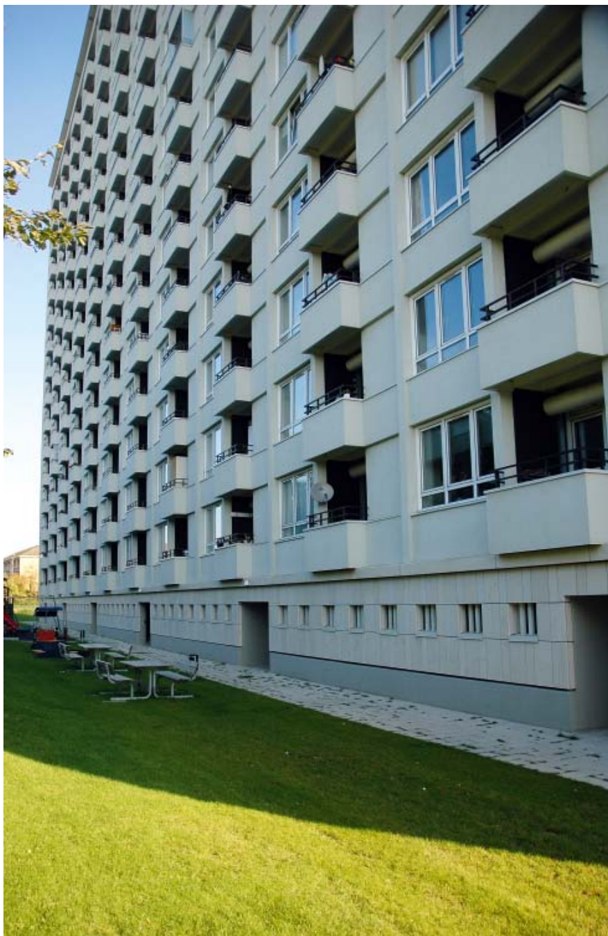
Figur 83. Højhuset efter renovering.
