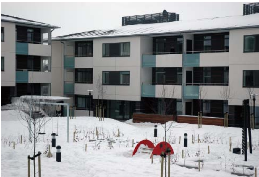
Figur 8. Renoveringen af Skelagergårdene. Udgangspunktet for renoveringen - facadernes og gårdrummenes proportioner, var godt. Det har renoveringen bygget videre på.
