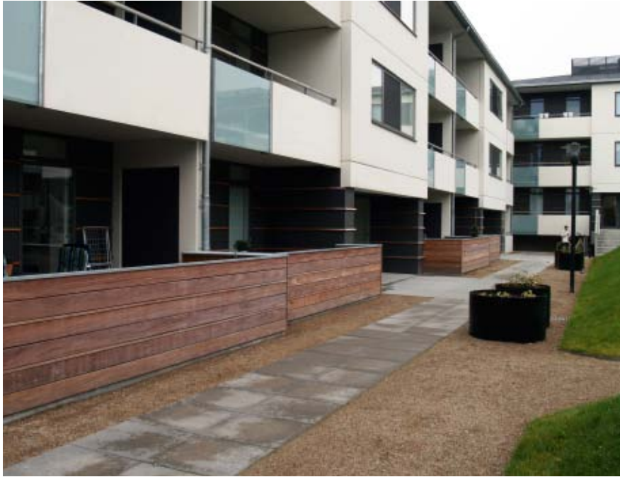
Figur 91. Gårdfacaden efter renovering.
