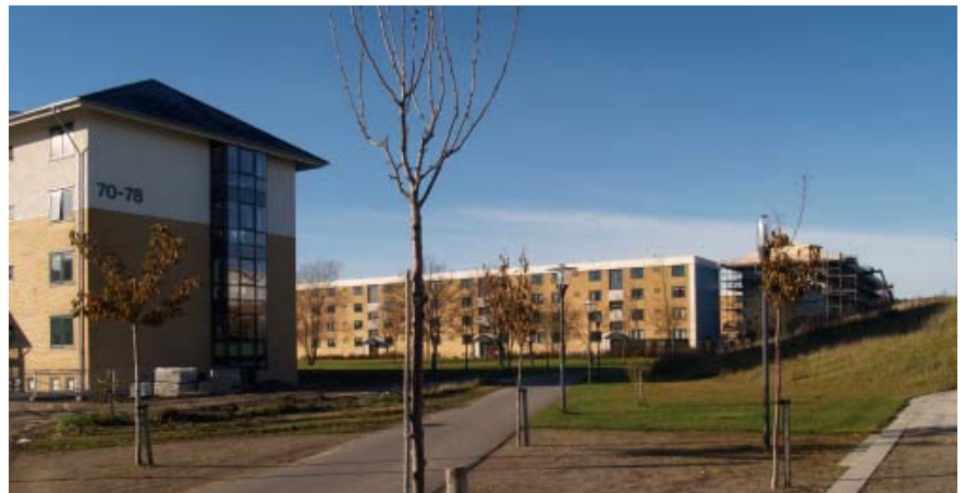
Figur 21. Nye tage med lav rejsning og udhæng i Hånbæk.
