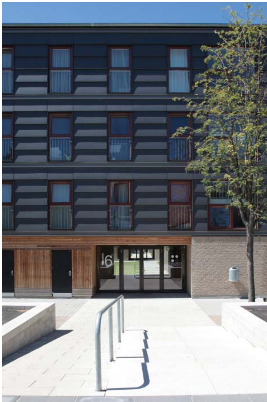
Figur 54. Ramper ned til indgangene, hvor trin er blevet udlignet til stueetagerne.
