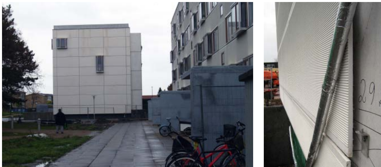
Figur 19. Efterisolering af Gyldenrisparken beklædt med fiberbetonplader med rillet struktur.
