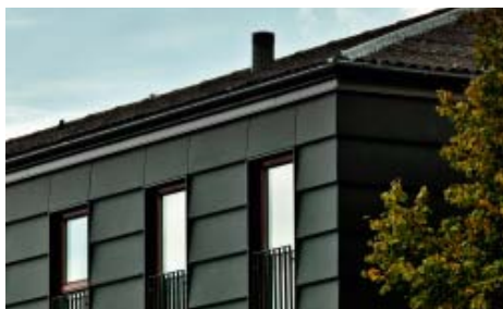
Figur 9. Til venstre: Sprotoften, hvor taget er blevet hævet og fået et udhæng. Til højre: I Albertslund Nord har efterisoleringen af facaderne haft uheldige konsekvenser for mødet mellem tag og facade.
