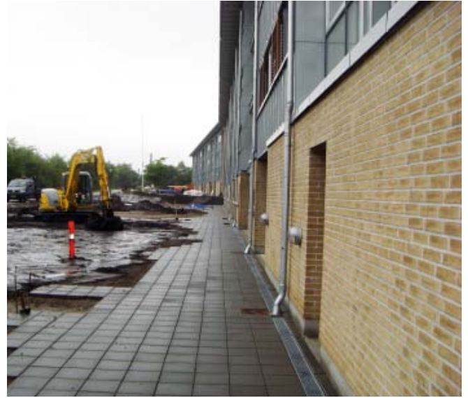
Figur 18. Nye facader i Høje Kolstrup beklædt med tegl og zink, der forventes at patinere smukkere end de oprindelige.
