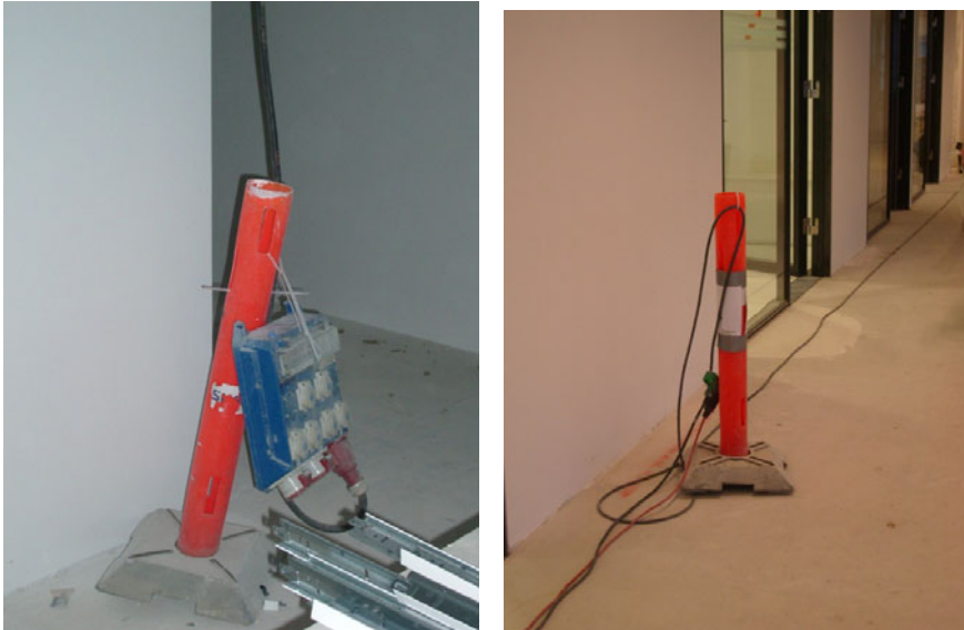
Figur 13. Ophængning af undertavle og ledninger på kegler for at få styr på løse ledninger.
