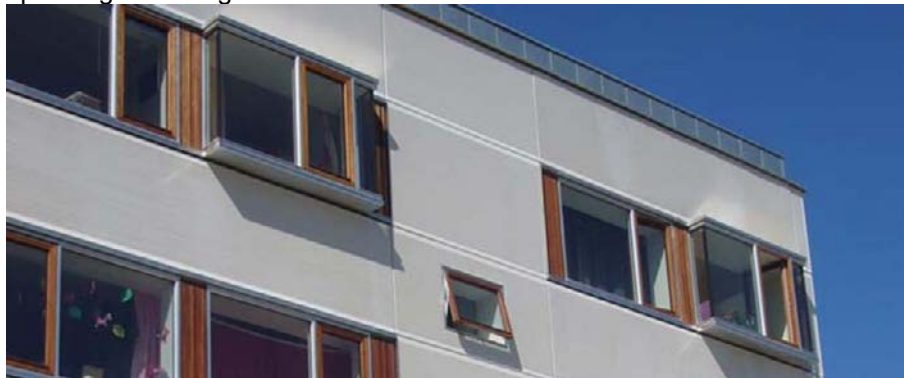
Figur 30. Gyldenrisparken på Amager kan ses som eksempel på renovering, hvor mange indsats er samlet i en og sammen renovering, og hvor facaderenovering med indbyggede energibesparelser blot er en af de ting, der er opnået. Foto: Witraz.
