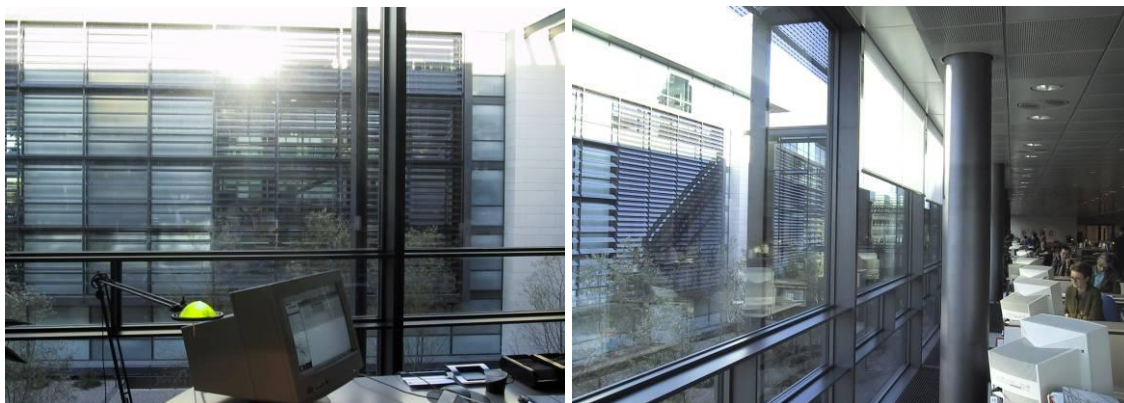
Figur 5. Udsigt gennem nordfacader i en kontorbygning. På grund af generende reflekser fra sydfacaden af den modstående bygning, har det været nødvendigt at montere indvendige screen mod nord.
