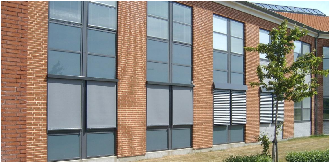
Figur 36. Udvendigt foto af det udvendige gardin (til højre i billede) og den nye persienne (til venstre i billede). De to solafskærmningssystemer blev monteret på to vinduesfag.
