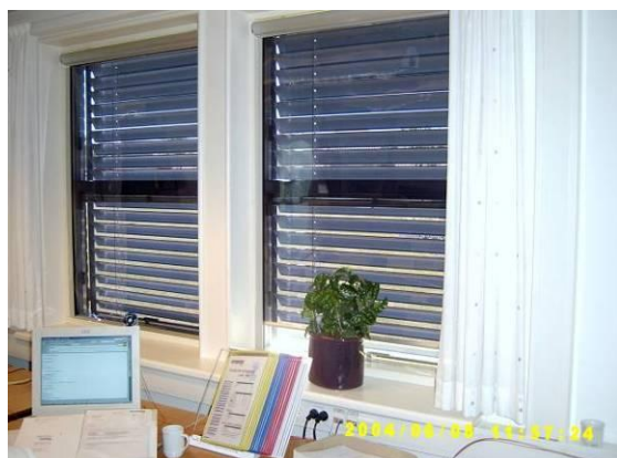
Figur 36. Udvendigt foto af det udvendige gardin (til højre i billede) og den nye persienne (til venstre i billede). De to solafskærmningssystemer blev monteret på to vinduesfag.
