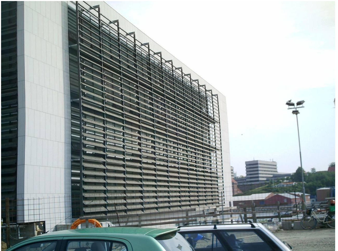
Figur 54. Sydfacade på testbygningen.
