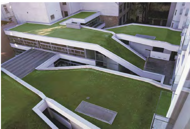
[4.42] Foto viser erhvervslokalernes tagflade i gårdrummet set fra boligerne.
