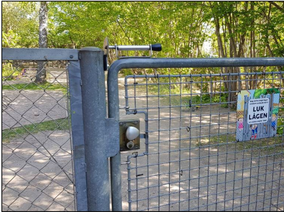
FIGUR 34. Eksempel på den nye lukkemekanisme på lågen ind til legepladsen i daginstitutionen Nøddehegnet i Gladsaxe Kommune. Foto: Sidse Grangaard.
