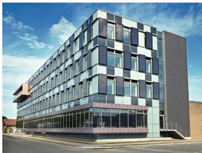
EnergiMidts nye administrationsbygning i Silkeborg, der er bygget efter energiklasse 2015. 89 % af medarbejderne siger, at den lever op til deres forventninger. Foto: Carl Stephansen.
