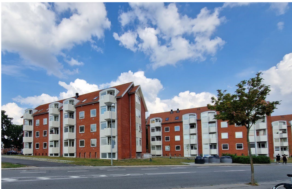
Figur 15. Højstrupparken – de 15 boliger i blokken til venstre på billedet har fået installeret behovsstyret ventilation og har sammen med de 15 boliger i blokken bagved med balanceret mekanisk ventilation leveret indeklimadata til undersøgelsen. Foto: Turid Borgstrand Øien.
