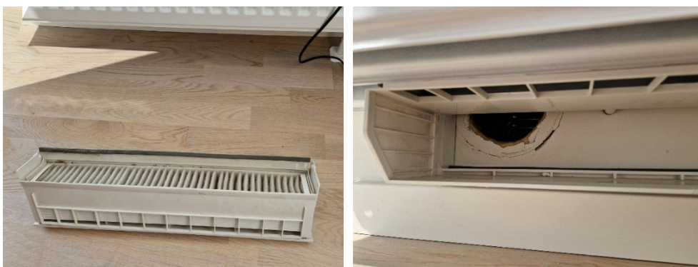
Figur 16. Armatur for luftindtag. T.v.: filter og styrespjæld for regulering af indtag. T.h.: udeluftventil i facaden. Fotos: Turid Borgstrand Øien.
