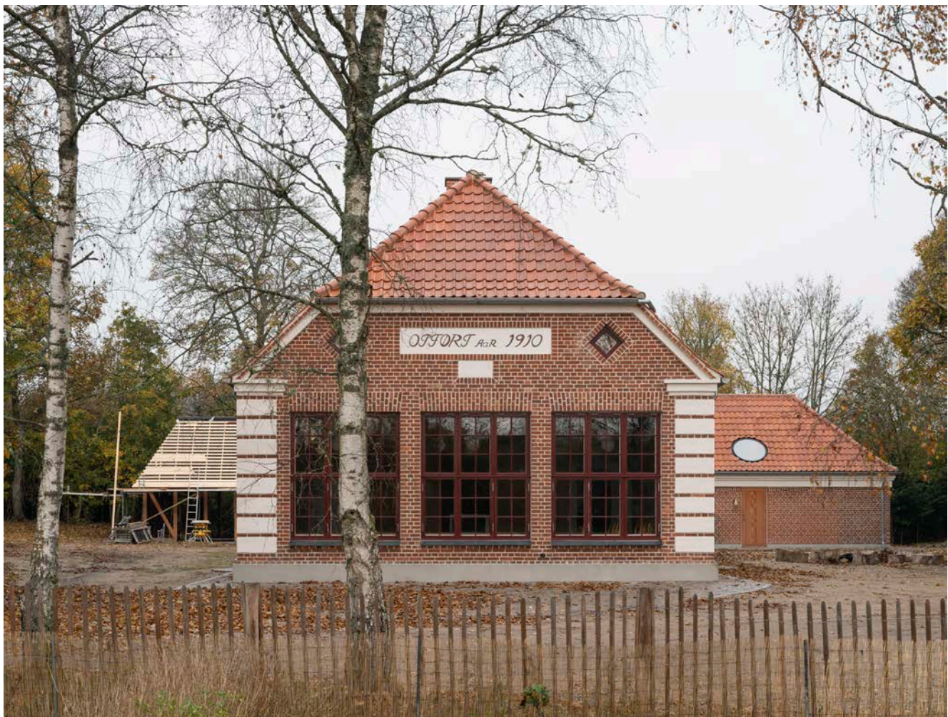
↑ Øverst: Hovedbygningen under renovering Foto: Hampus Berndtson
