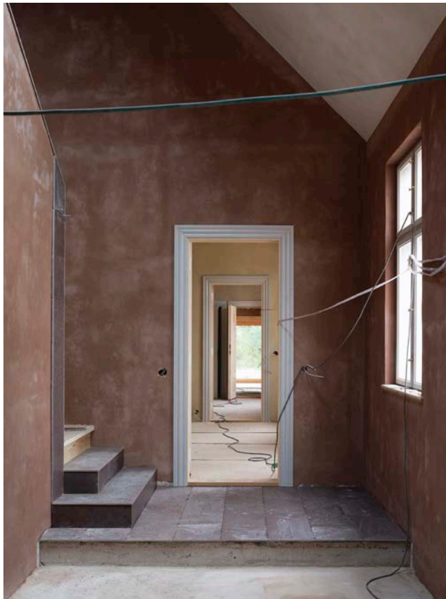
↑ Hovedbygningen under renovering. Terrændæk i kalkbeton
