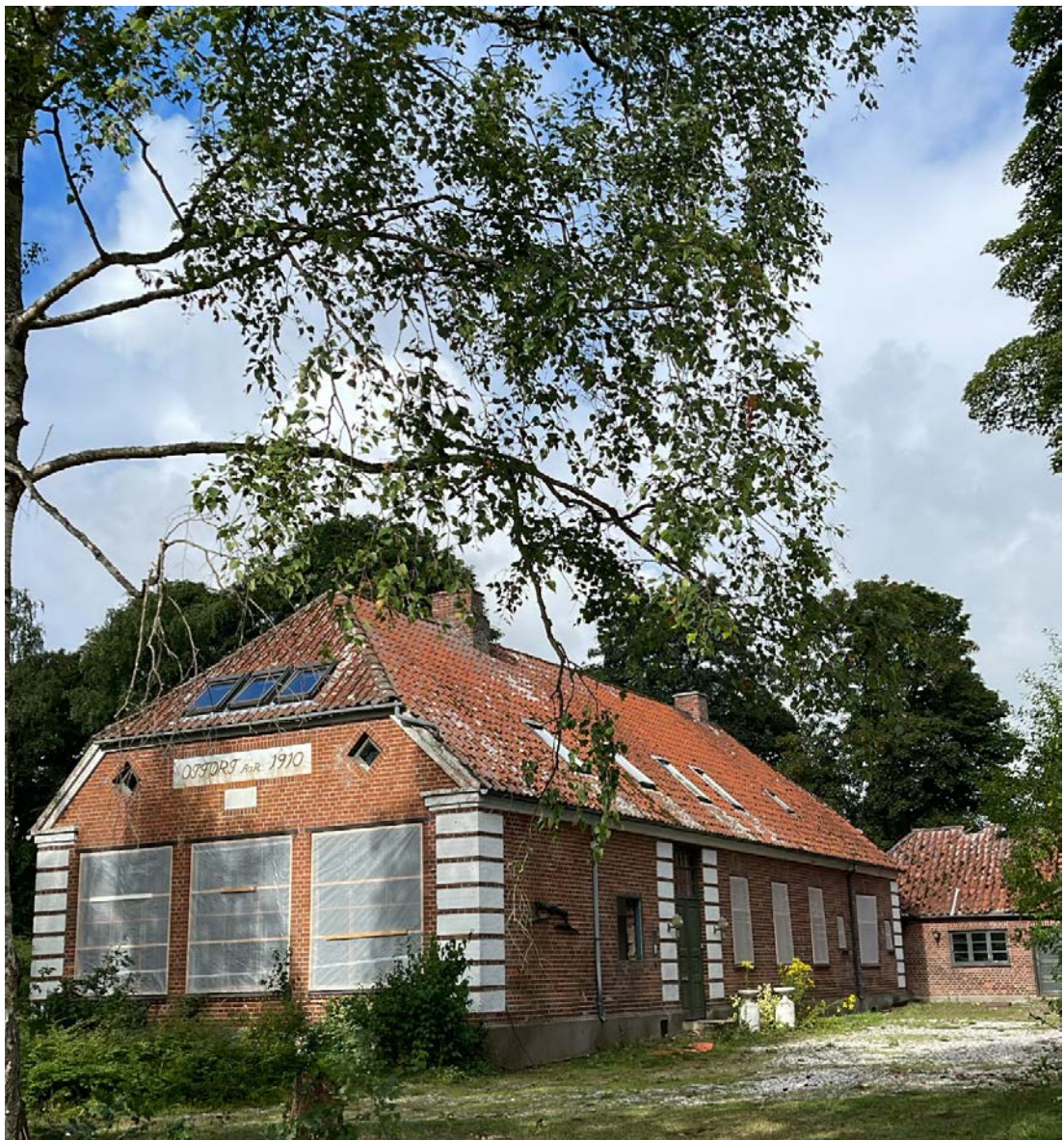
↑ Bygningen under renovering
