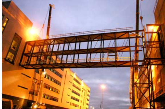
Gangbro mellem bygningerne ved dens montage.
