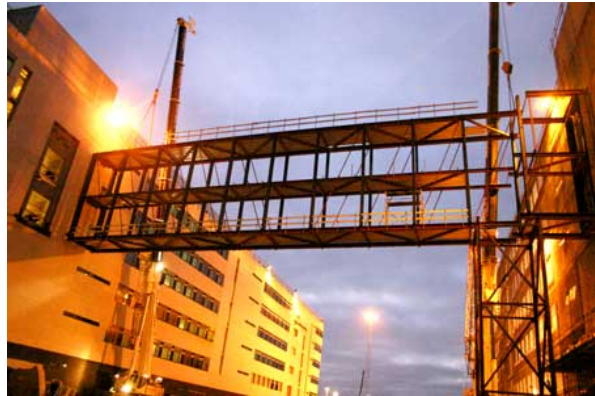
Gangbro mellem bygningerne ved dens montage.
