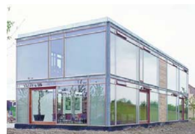
Det højisolerede glashus(1999) . SBI-rapport 317
