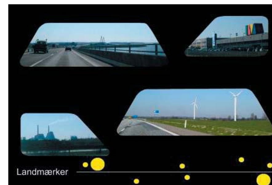
Figur: Landmærker. De store bygværker, der fungerer som landmærke og orienteringspunkter for trafikanterne. Det er bygværker som broer og kraftværker, der alene ved deres størrelse bliver synlige i længere tid, og som ved deres arkitektur kan fremstå som unikke på rejser over lange afstande. For delstrækninger kan mindre unikke bygværker, som ved deres placering i forhold til motorvejen, også få betydning som landmærker. Det kan være markante erhvervsbygninger, vindmøller eller bygningselementer som skorstene, som kan opleves tydeligt over længere afstande.
